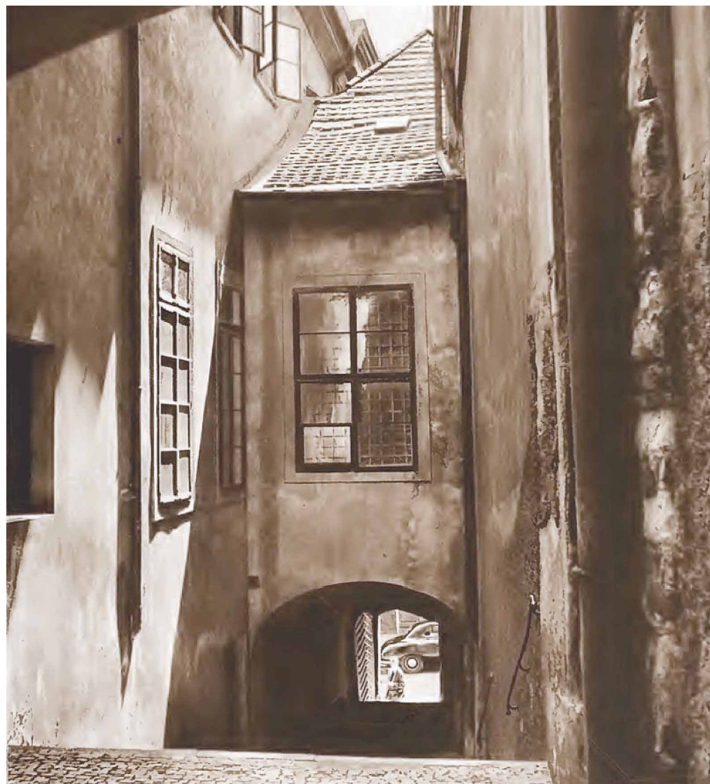
Ulička mezi Thunovskou a Nerudovou ulicí, s chodbou spojující italskou ambasádu s kostelem U Kajetánů v době akce StB
